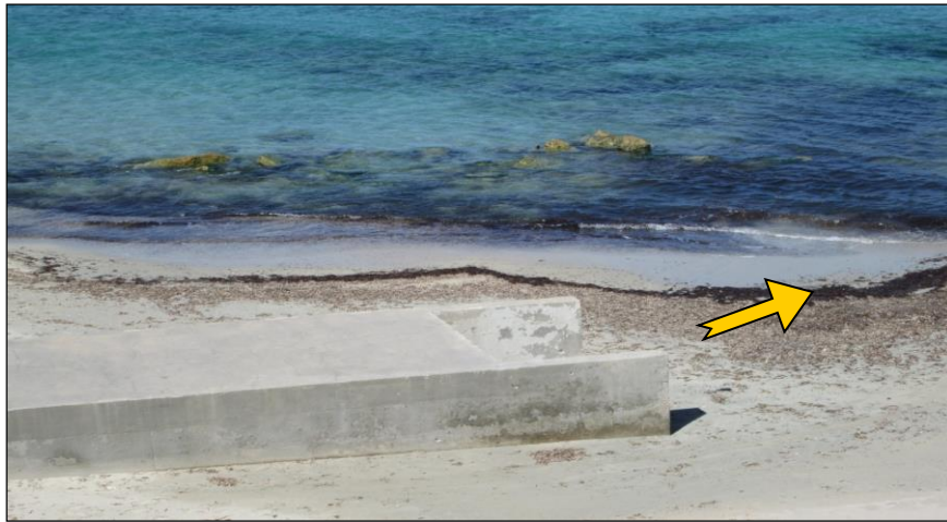
شكل 3. أنبوب تصريف مياه الصرف الصحي الغير معالجة غرب مرسى زيتن (المصدر: عدسة الباحث عند القيام بالعمل الميداني)
