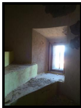
(أ) تفتت الحجارة نتيجة الرطوبة (ب) تأثير عامل الرطوبة شكل (13) مظاهر التلوث البيئي على المنارة البحرية (عدسة الباحثان بتاريخ أغسطس 2016م)
