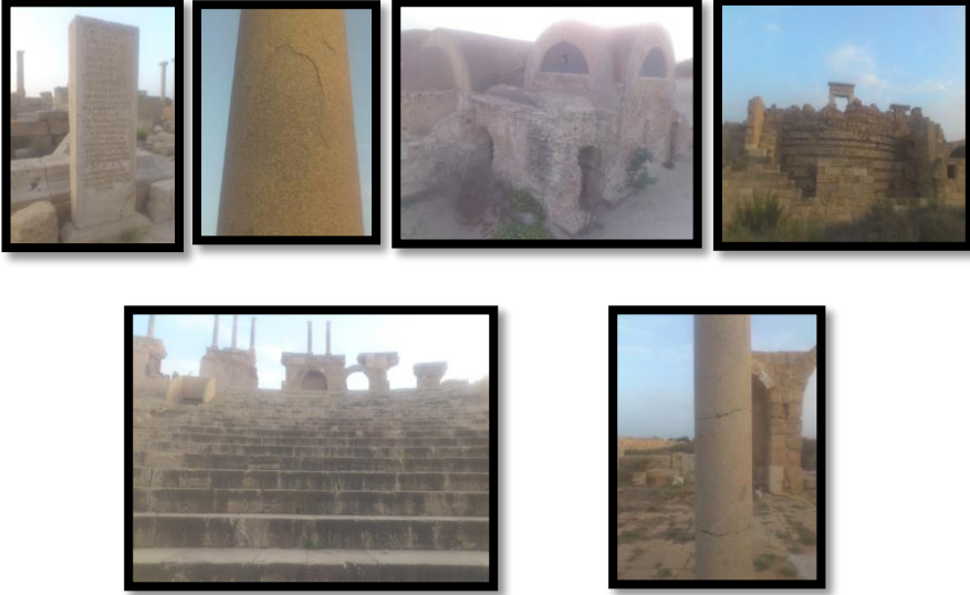
(أ) تفتت الحجارة (ب) عامل الرطوبة (ج) تفتت الحجارة (د) نمو النباتات و تأثير أملاح البحر (هـ) تشقق الأعمدة (و) اسوداد أسطح الحجارة
