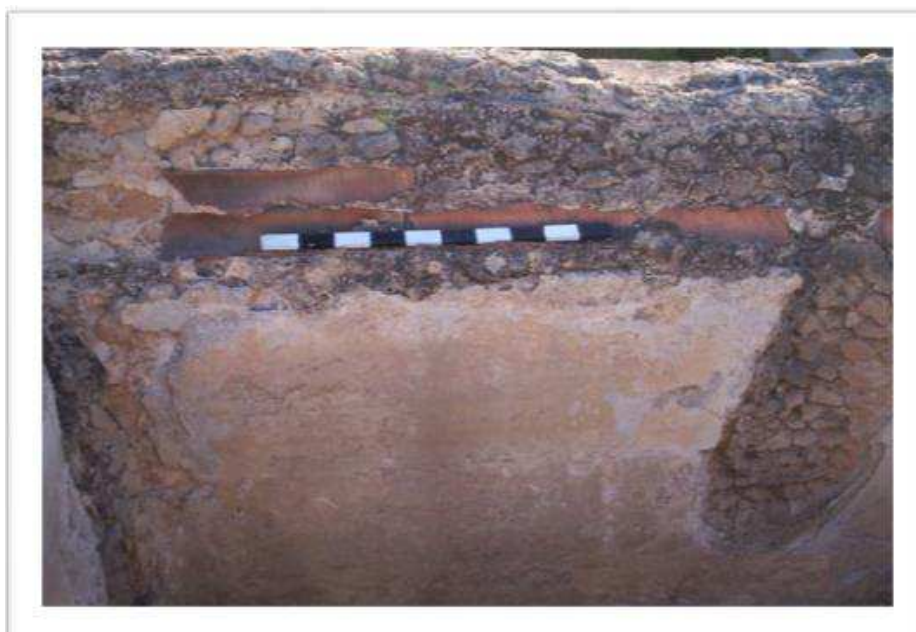
(الصورة 17) استخدام قنوات فخارية في إنشاء أقبية مبنى الخزانات الثلاث.
