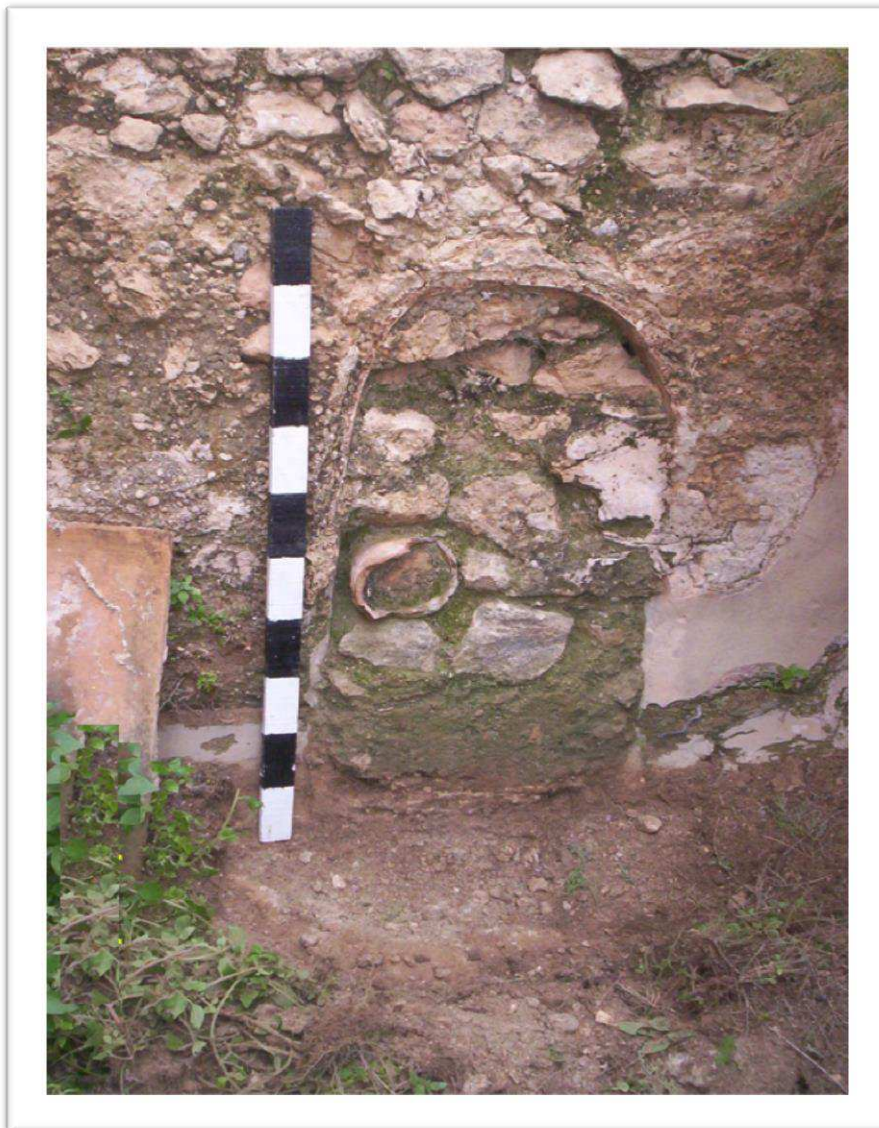
(الصورة 16) فتحات كانت تعمل على توصيل المياه بين الخزانات الثلاثة وتم
