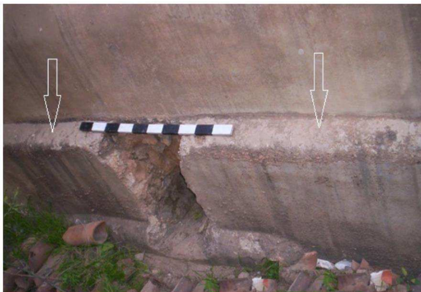
(الصورة 13) تقوية الخزان من الأسفل بواسطة دعائم مستطيلة تمتد على جانبه بشكل رأسي.
